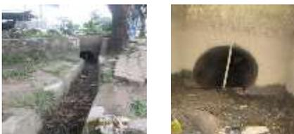
**Gambar 6.** Kondisi eksisting saluran drainase di simpang jalan Johar-Yasmin
