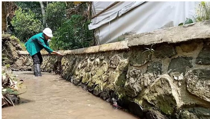
Gambar 2. Pengukuran Panjang Kerusakan pada Tanggul Saluran Sungai Sumber: Foto Sendiri Berlangsung di Lokasi.
