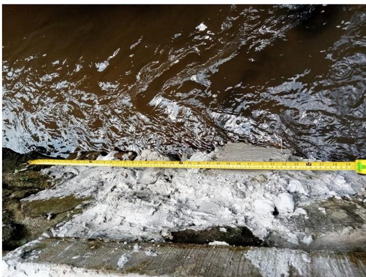
Gambar 6. Foto Pengukuran Panjang Perbaikan Tanggul Saluran Sungai Menggunakan Meteran Sumber: Foto Sendiri Berlangsung di Lokasi.
