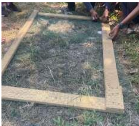
Gambar 8. Proses pemasangan kawat ram pada kayu
