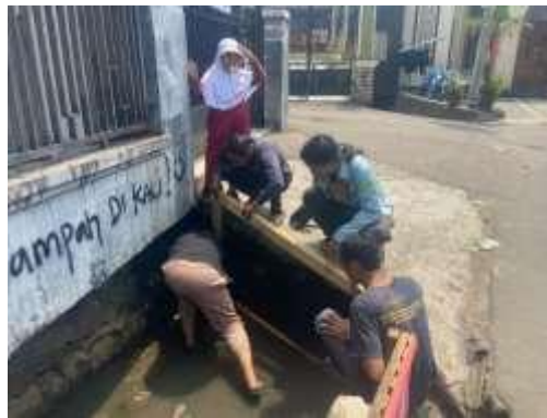
Gambar 9. Proses pemasangan AFS pada titik saluran air
