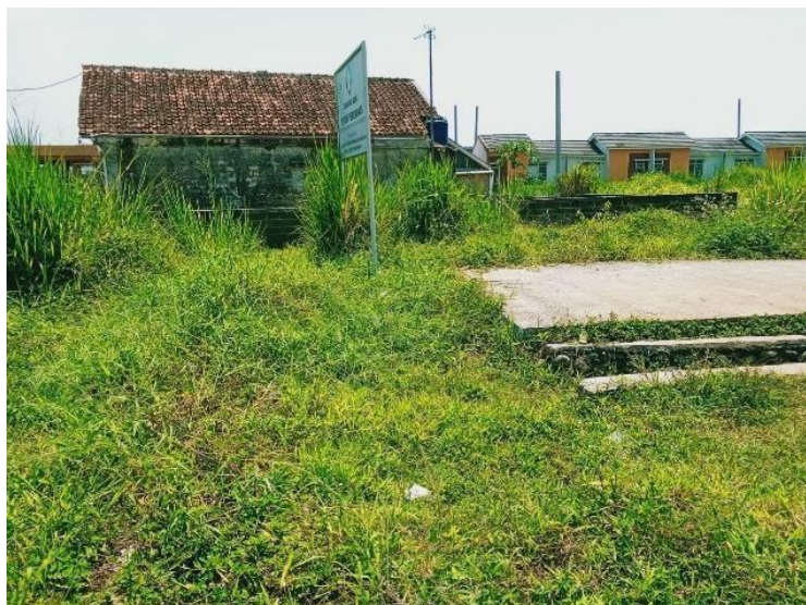
Gambar 4. Jalan air yang terpotong.
