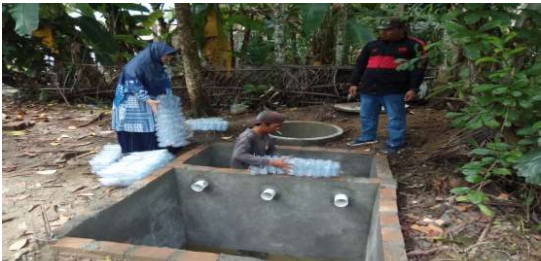
Gambar 4. Pendampingan Pembuatan Septitank dan Pemasangan Biofilter Ramah Lingkungan
